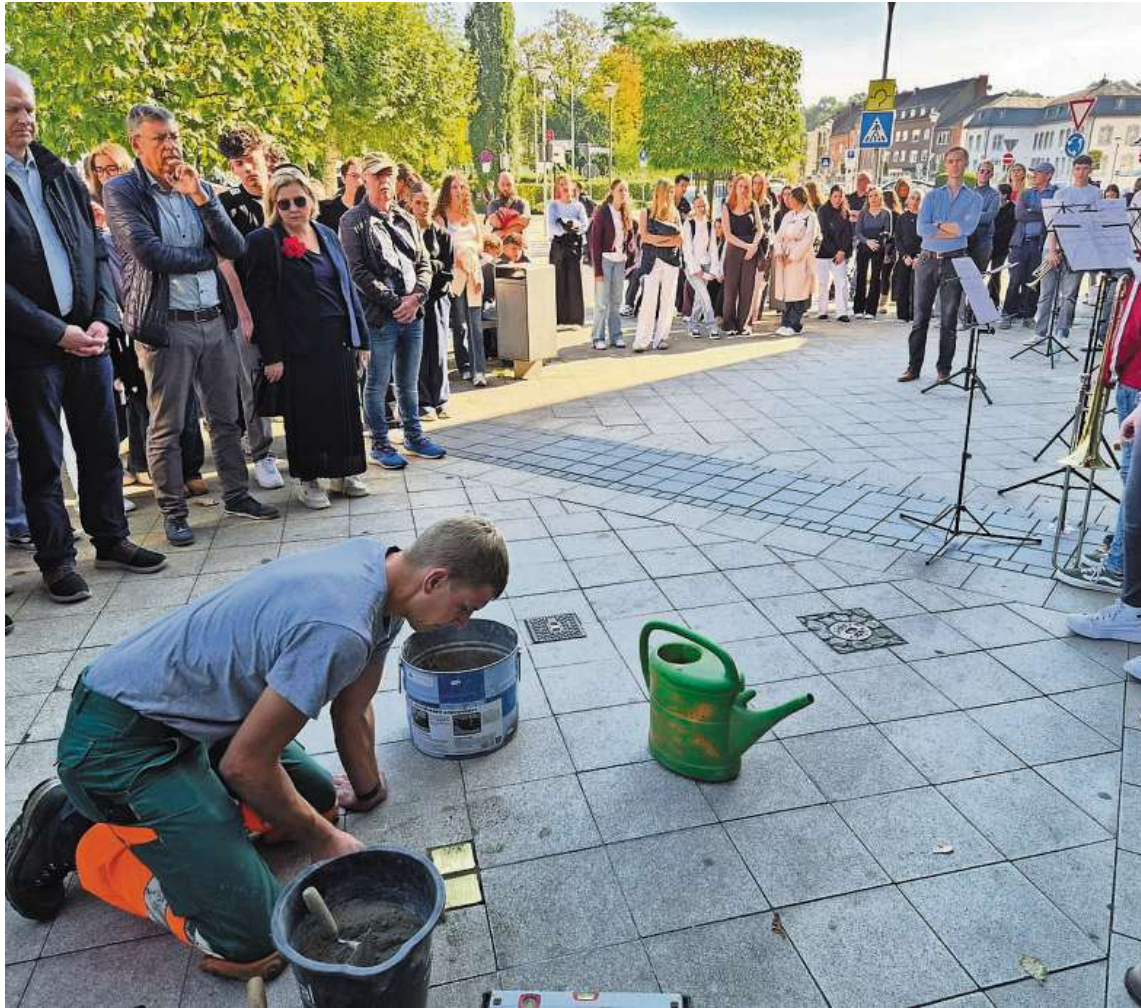
In der Geilenkirchener Innenstadt wurden in würdigem Rahmen mehrere Stolpersteine erneuert und einer neu verlegt.
